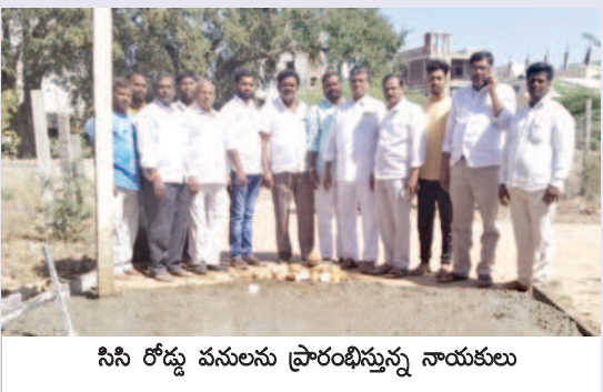
సిసి రోడ్డు పనులను ప్రారంభిస్తున్న నాయకులు
